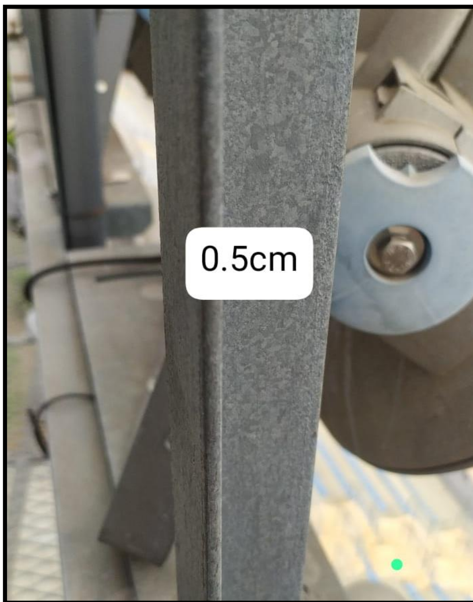
Perifl L existente na estrutura de fixação dos projetores: 2" x 3/16"
