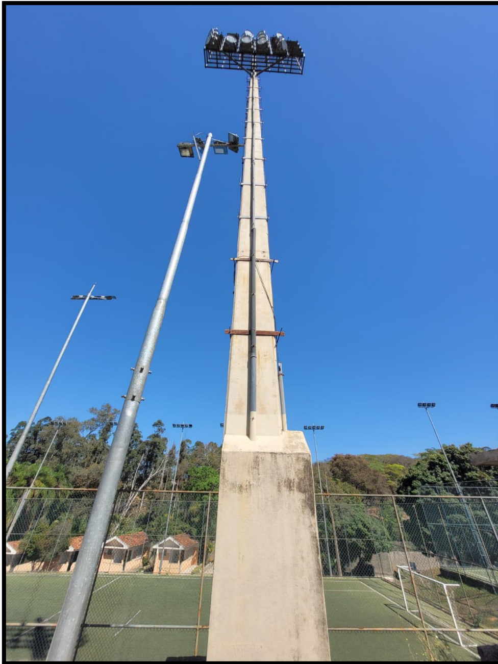
Instalação em poste duplo T – 25 metros de altura
