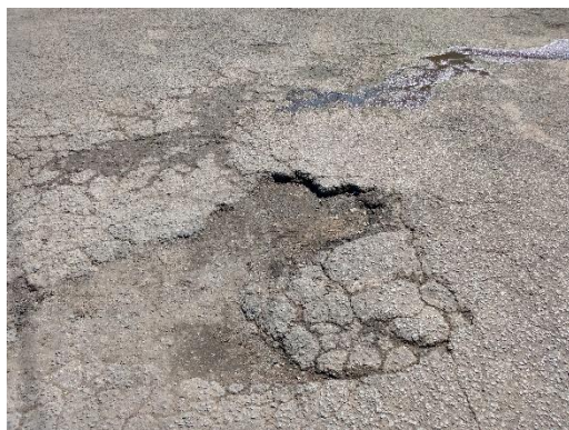
Foto 03: Aspecto da pavimentação asfáltica atual.
