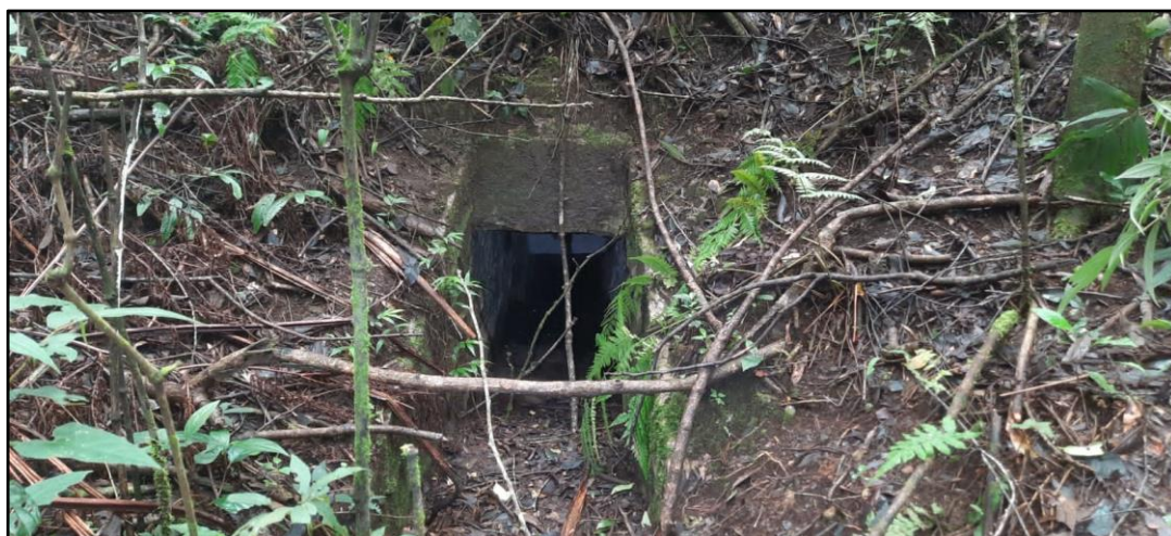
Figura 4.12 – canal de seção retangular abaixo da linha férrea.
