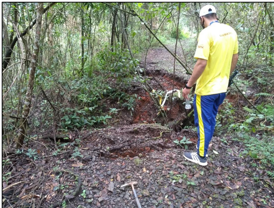
Figura 4.11 – Vista para trecho da linha férrea colapsada possivelmente por um processo de erosão interna.
