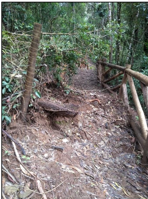
Figura 4.2 – Massa rompida obstruindo a trilha e proveniente de talude à montante.
