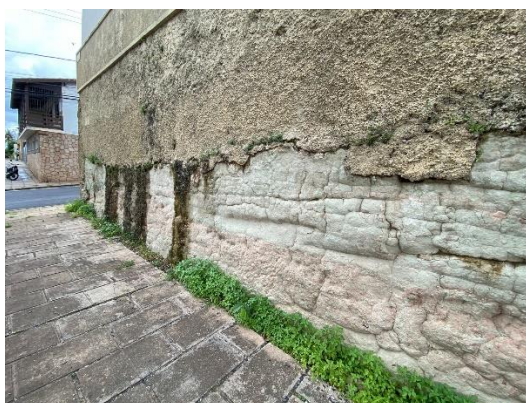
Foto 07: Muro externo infiltrações
