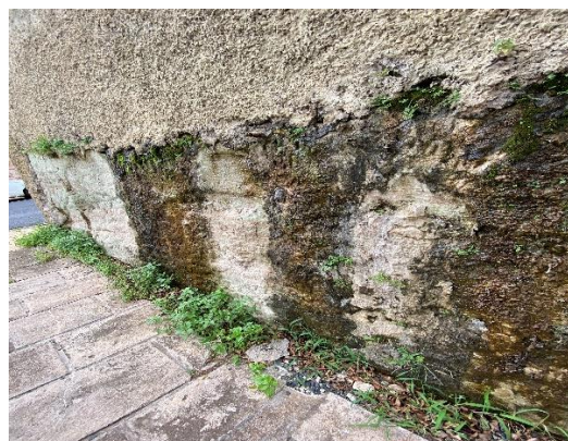
Foto 08: Muro externo infiltrações
