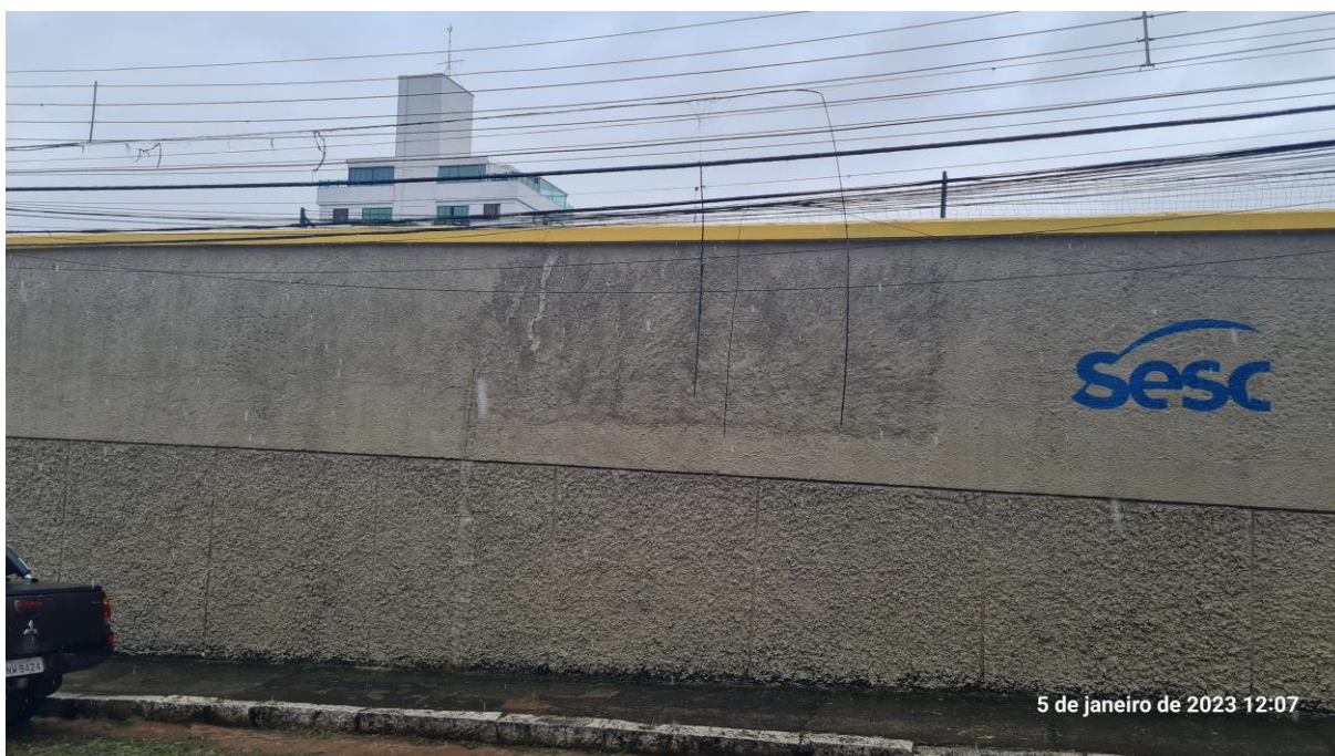
Figura 9 - Mostra trecho na Rua Virgínia onde a junta de dilatação foi descontinuada
