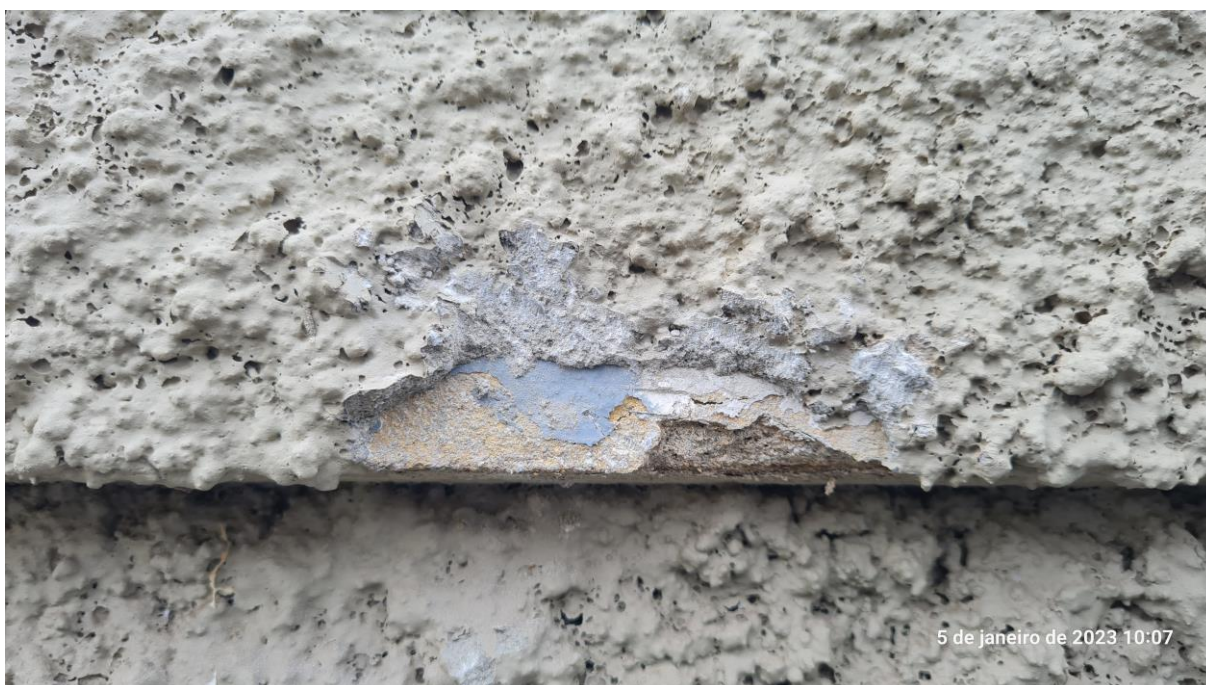
Figura 3 - Mostra inspeção feita a marreta em trecho da Rua Brasília onde o revestimento apresenta som oco a percussão
