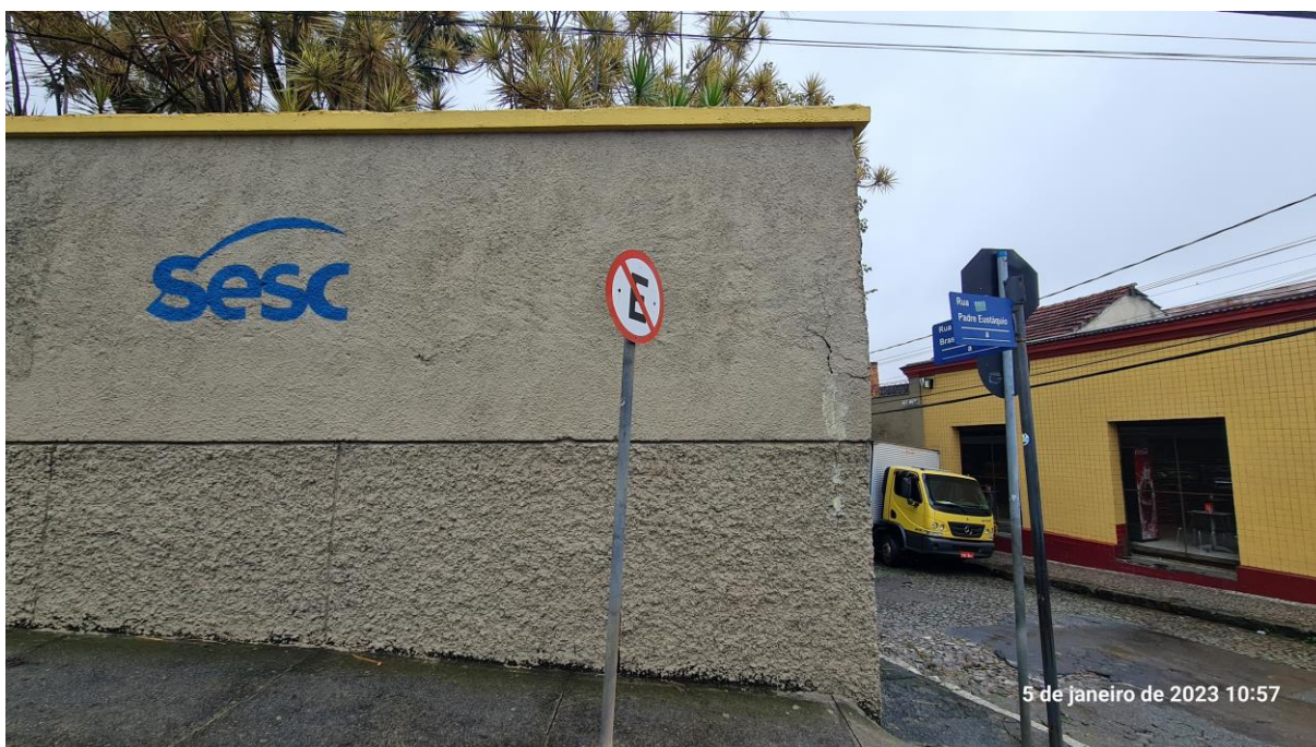
Figura 4 - Mostra trecho na esquina das ruas Brasília com Padre Eustáquio com trincas na alvenaria e deslocamentos de revestimentos
