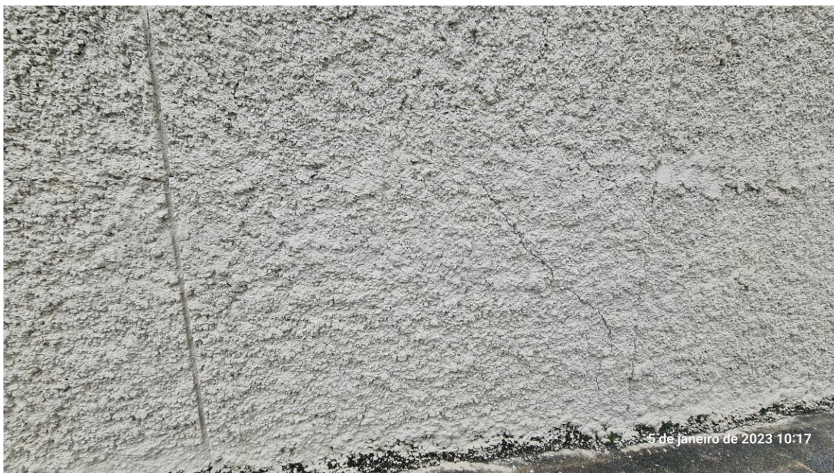
Figura 1 - Mostra trecho na Rua Brasília com deslocamentos e trincas nos revestimentos
