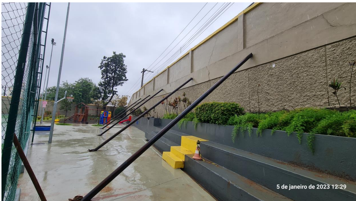
Figura 8 - Mostra trecho visto na Figura 6, interno à unidade, em trabalhos de escoramento
