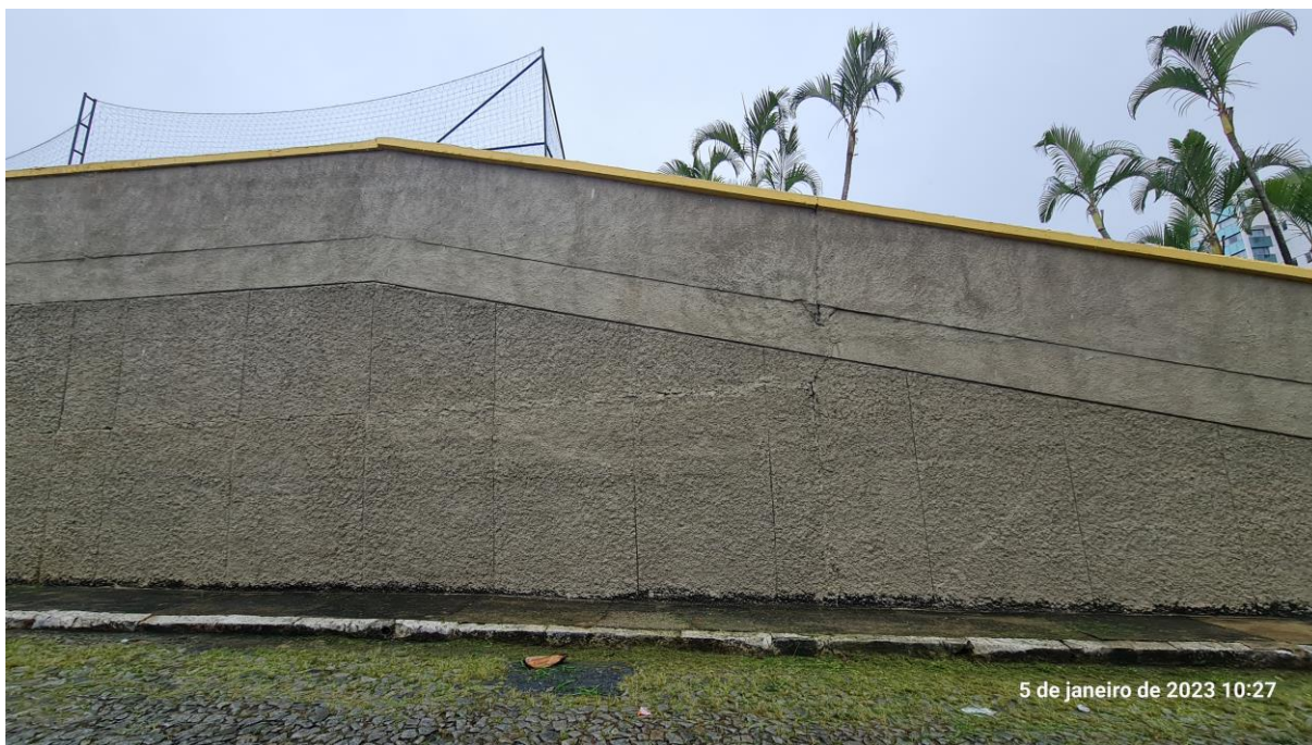
Figura 2 - Mostra trecho na Rua Brasília com trincas verticais onde a junta de dilatação foi descontinuada em alteamentos realizados em obras anteriores e trincas verticais no trecho provável de transição do muro de arrimo para vedação
