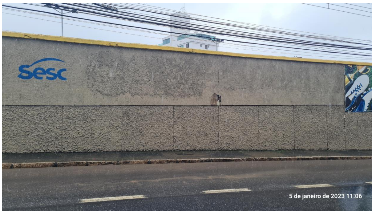
Figura 6 - Mostra trecho na Rua Padre Eustáquio com fraturas verticais que descontinuaram as alvenarias ocasionando desaprumo
