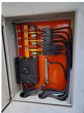
Figura 2 - Quadro Geral de Baixa Tensão da unidade
