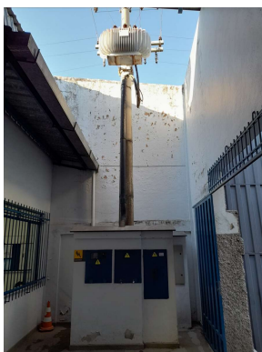
Figura 1 – Caixa de medição Cemig com chave de proteção geral da entrada de energia
