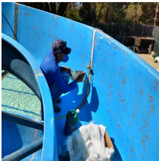
Foto 17: Aplicação da fibra de vidro.
