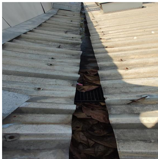
Foto 26: Calhas a serem substituídas.
