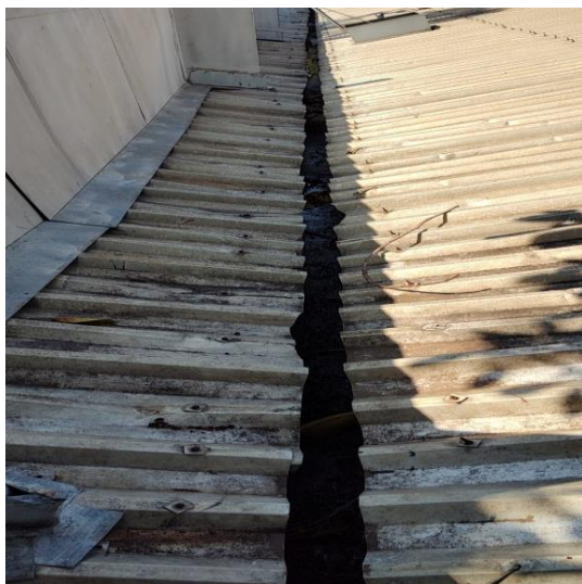
Foto 25: Calhas a serem substituídas.
