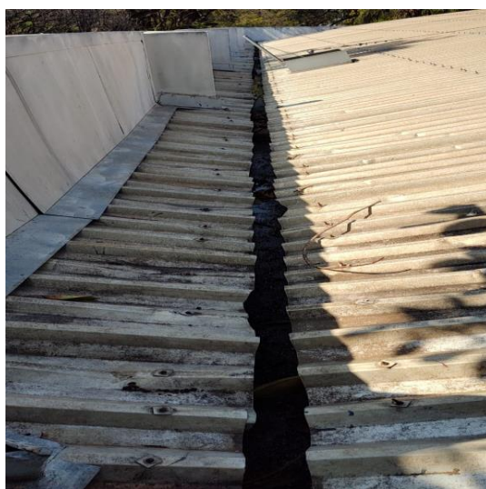
Foto 20: Calhas a serem substituídas.
