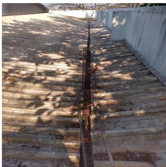
Foto 19: Calhas a serem substituídas.
