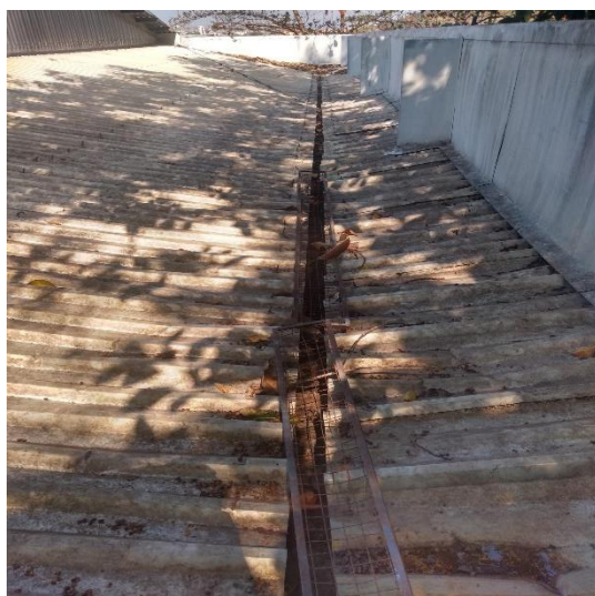
Foto 19: Calhas a serem substituídas.
