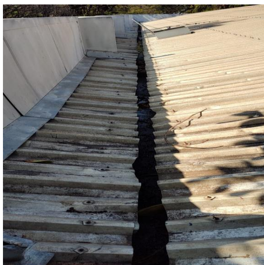
Foto 20: Calhas a serem substituídas.
