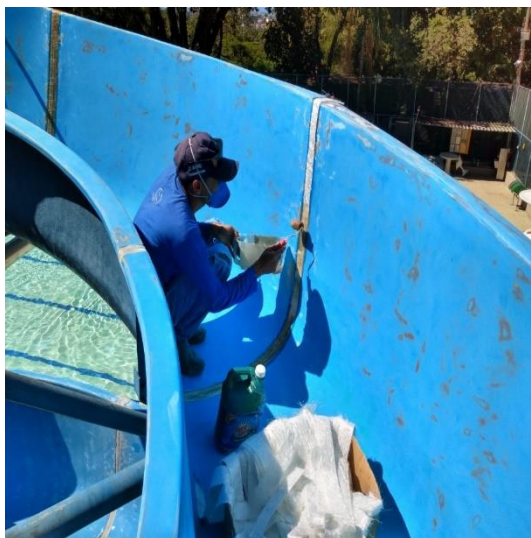
Foto 17: Aplicação da fibra de vidro.
