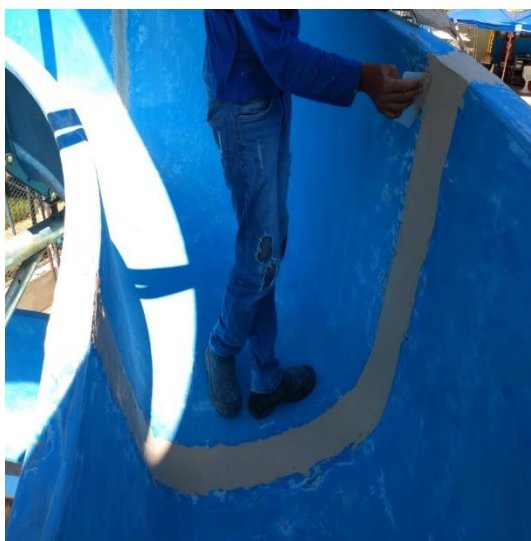
Foto 18: Aplicação da massa de poliéster.
